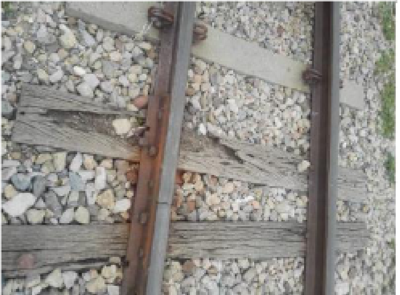
Figura 15 Astilladura e intercalado de durmientes en vía
